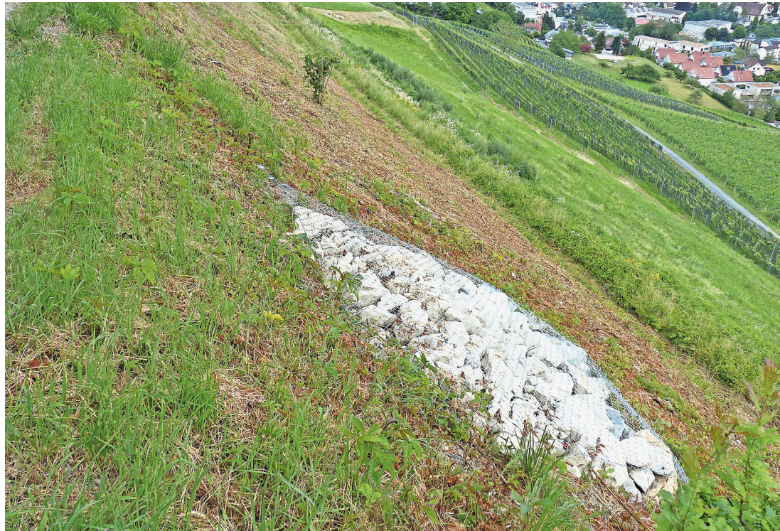
Die neue Steinlinse wurde mit einem Gitter gesichert, da der Hang sehr steil ist. Die Terrassierung des Rebbergs ist noch nicht abgeschlossen.
