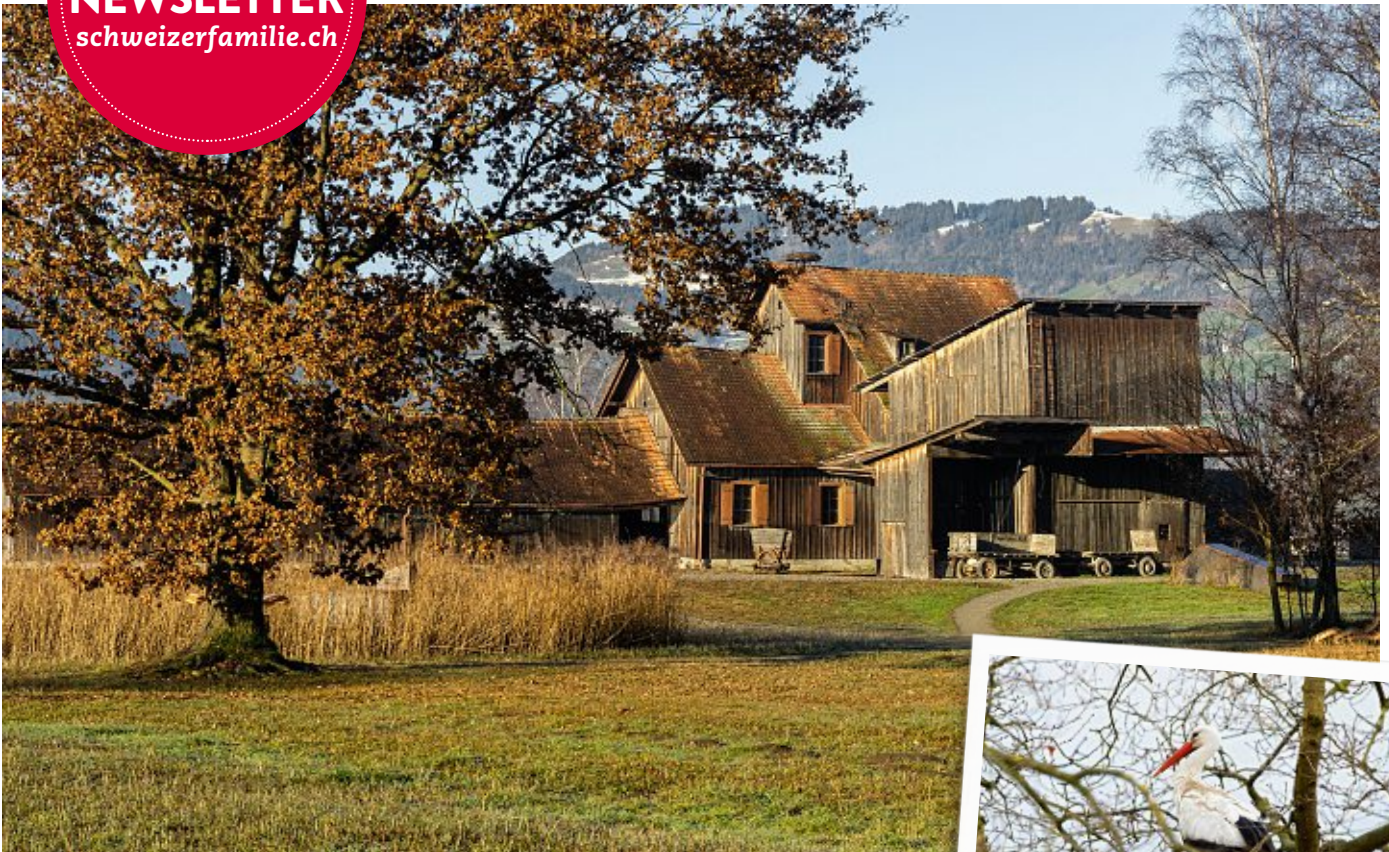
Sieht aus wie bei den Goldgräbern in der Prarie: Der Gebäudekomplex der ehemaligen Schollenmühle mitten im Riet.
